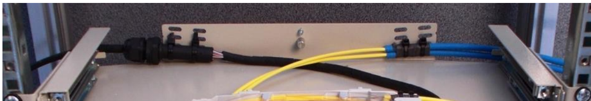
Fot.1 Instalacja kabli liniowych w panelach
